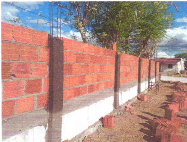
FOTO 03 - ARMAÇÃO DE PILAR OU VIGA DE ESTRUTURA CONVENCIONAL DE CONCRETO ARMADO UTILIZANDO AÇO CA-50 DE 10,0 MM - MONTAGEM. AF_06/2022
