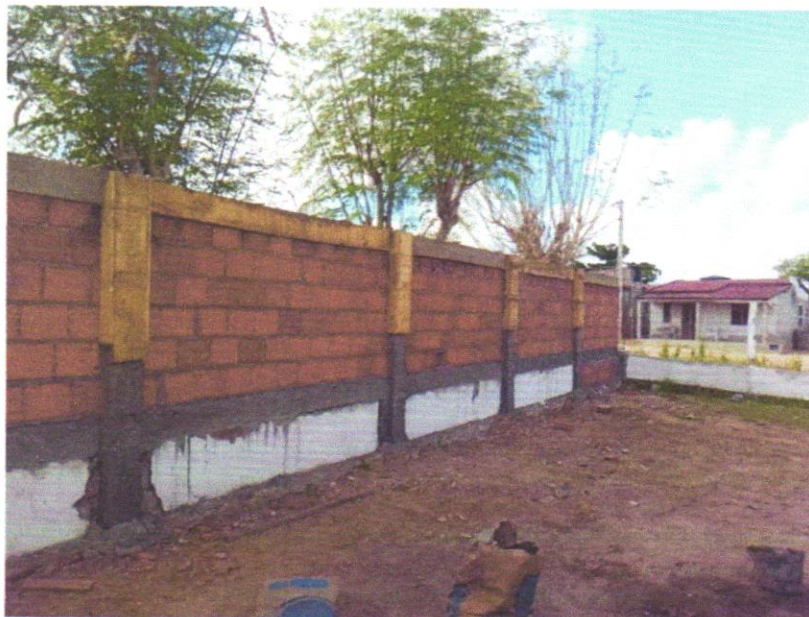
FOTO 05 - Alvenaria bloco cerâmico vedação, 9x19x24cm, e=9cm, com argamassa t5 - 1:2:8 (cimento/cal/areia), junta=1cm - Rev.09
