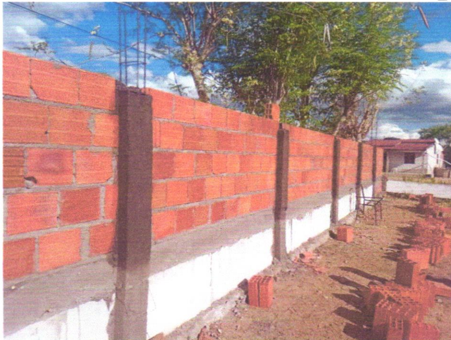
FOTO 08 - CONCRETAGEM DE PILARES, FCK = 25 MPA, COM USO DE BALDES - LANÇAMENTO, ADENSAMENTO E ACABAMENTO. AF_02/2022
